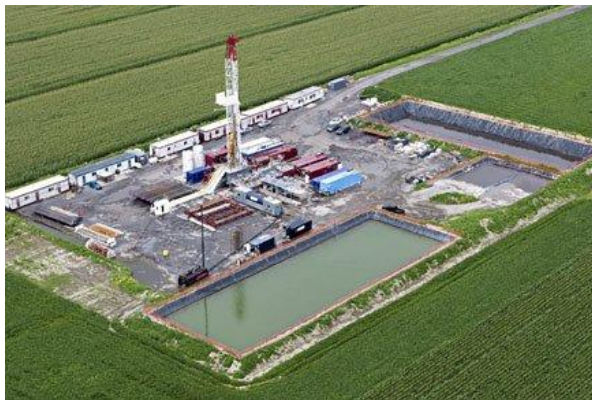
Puits avec bassins de décantation des produits nocifs qui remontent après fracturation.
